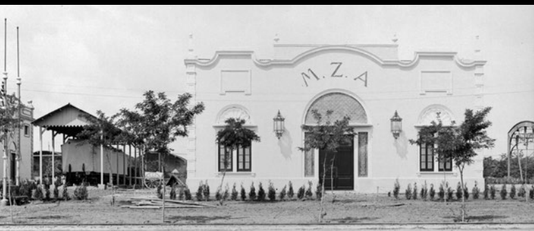
Exterior del pabellón de MZA en la Exposición Iberoamericana de Sevilla de 1929.
